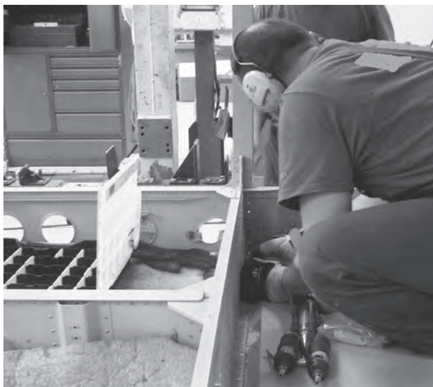
Rys. 3. Przykład uciążliwych prac montażowych wykonywanych w pozycji kucznej
