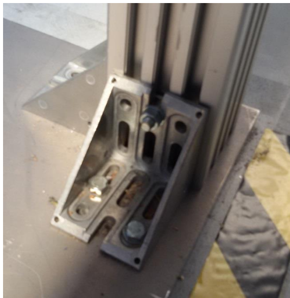
Rys. 4 Przykład mocowania słupów z profili aluminiowych do podstawy lub profili między sobą za pomocą kątowników aluminiowych
